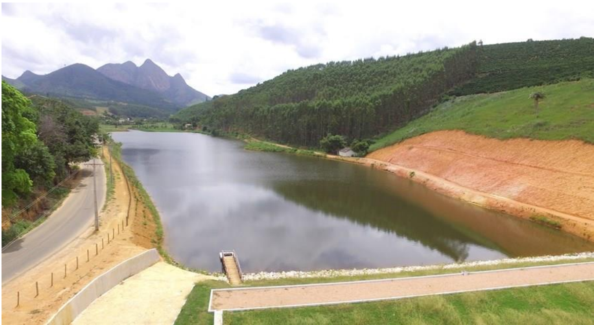
Figura 8. Programa Estadual de Construção de Barragens – ação do Governo do ES para o enfretamento à crise hídrica: Barragem Liberdade em Marilândia. Fonte: https://www.es.gov.br/Noticia/governo-entrega-primeira-barragem-e-inicia-duas-novas-obras , 2017.
